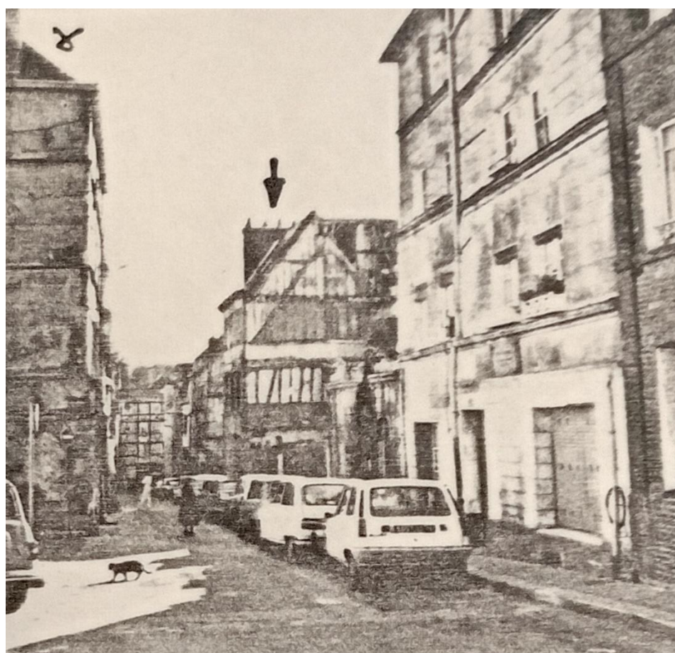
Le 19 rue Coignebert avant sa démolition (Archives municipales, photo issue du permis de détruire)
