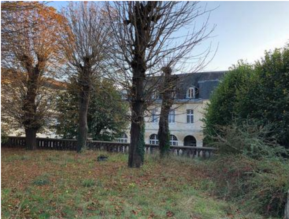
Bâtiment principal de l'ancienne maison des Mathurins, côté jardin, années 2010
