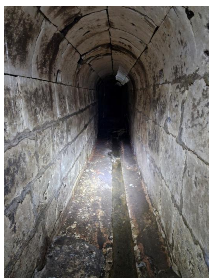
Aqueduc Saint-Nicaise sous la rue Saint-Nicaise, XIII e siècle. © Métropole Rouen Normandie
