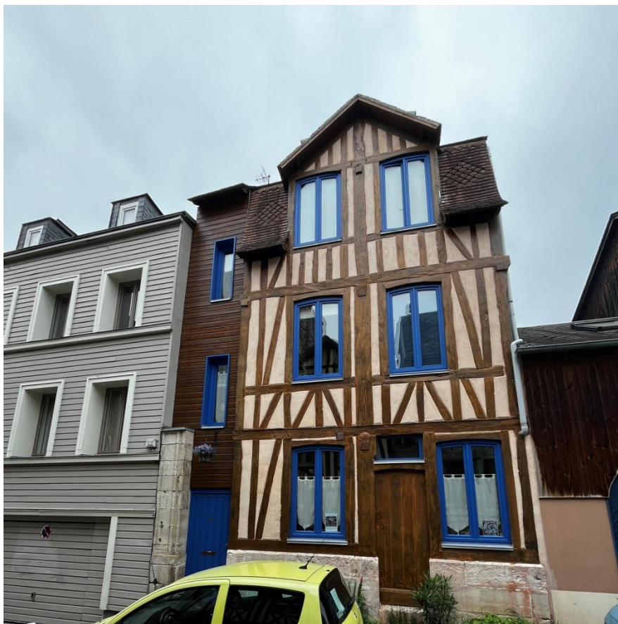
15 rue Coignebert, façade restaurée et remontée de la maison du 19. © BRL
